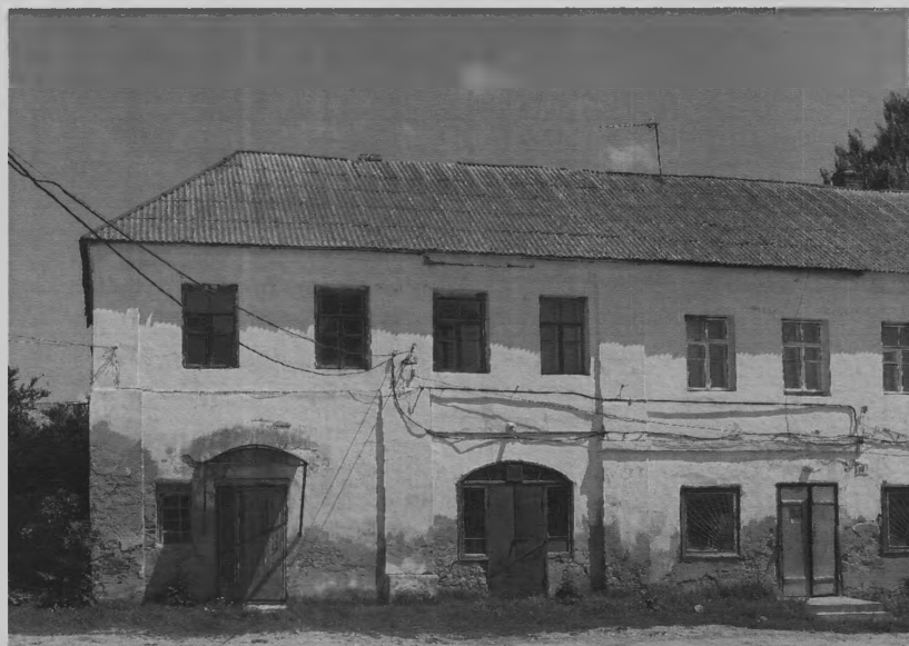
Рис. 3. м. Ізяслав. Будинок по вул. Заславська, 33; Фрагмент. Фото автора (2010р).
