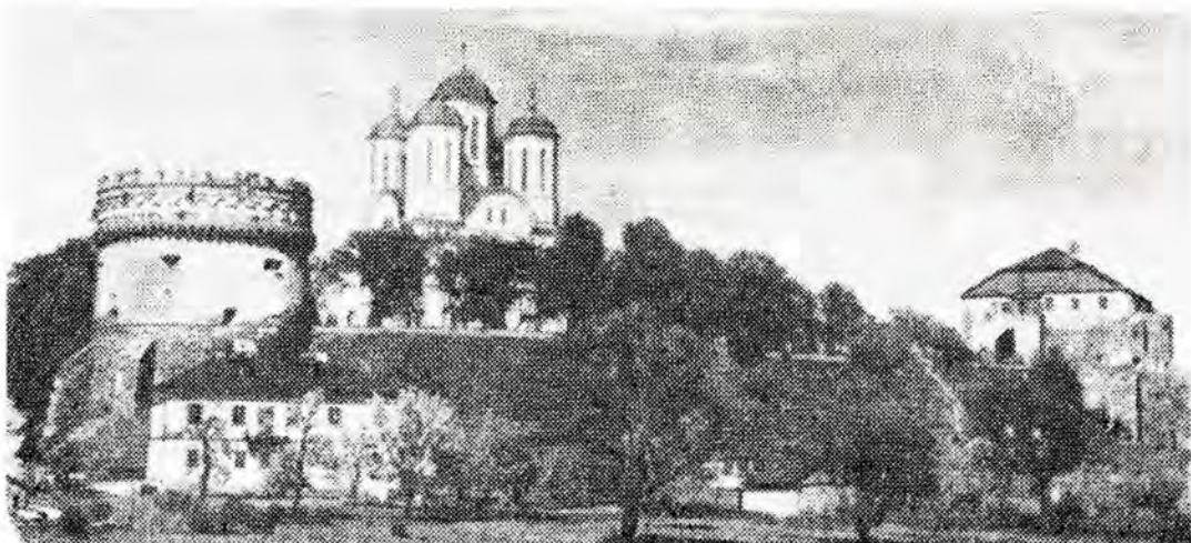
Загальний сучасний вигляд Замкової Гори в Острозі зі сторони Віллі (з півдня).
